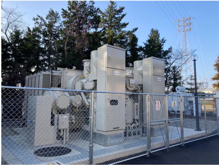
特高電気設備トランス更新（本社工場）
